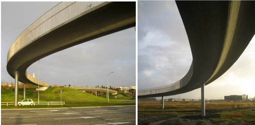
Mynd 3-2: Göngubrú á Hringbraut við Njarðargötu. Vinstra megin er horft til norðurs og hægra megin er horft til suðurs.
